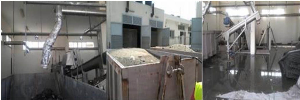
الشكل (3). عمليات الفصل الأولية لمياه الصرف الصحي. إعداد الباحثين.
